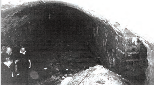
Voûte de la cave et décombres. A droite, début du couloir de la sortie des bêtes
