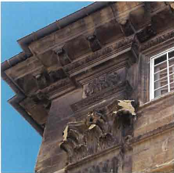
Chapiteau avant restauration
