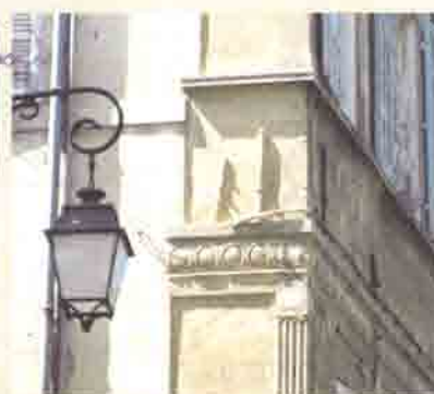
Décor Renaissance à l'angle des rues Maréchal Foch et des Marseillais
